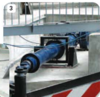
[1]-[3] Stemmtorantrieb Typ: K1R9 SWB, Hub = 3.300 mm, Ausführung mit kardanischer Lagerung, überflutungssicher
