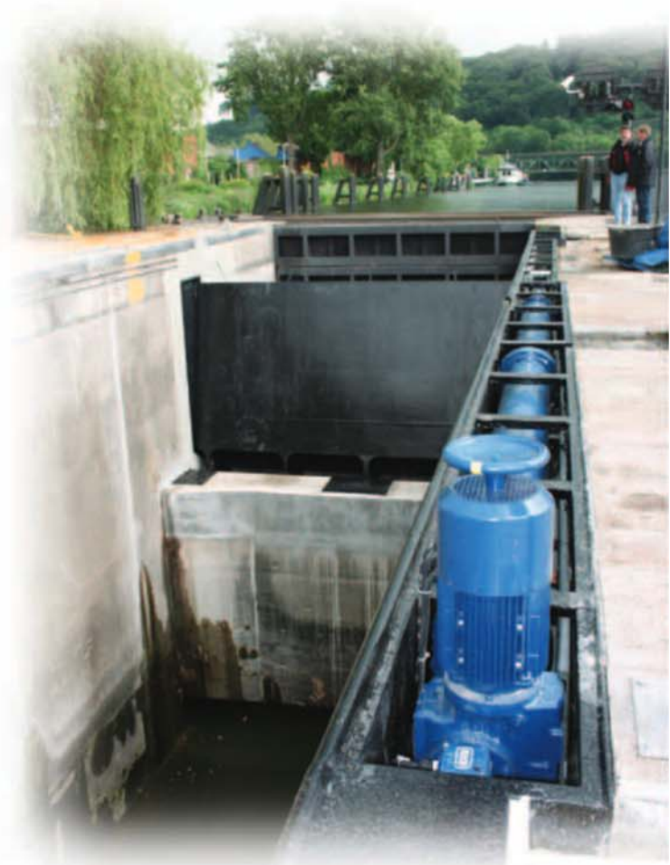
Zugsegmentantrieb Typ: K1R9 SWB, Hub = 5.500 mm
