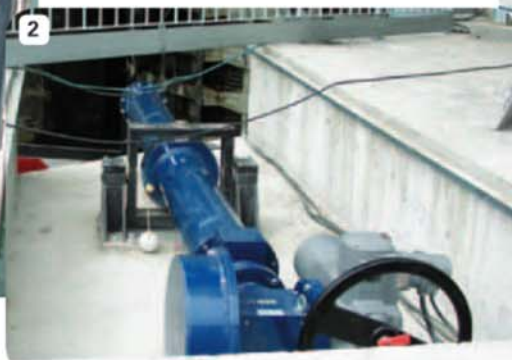
[1]-[3] Stemmtorantrieb Typ: K1R9 SWB, Hub = 3.300 mm, Ausführung mit kardanischer Lagerung, überflutungssicher
